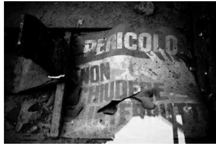
PERICOLO NON CHIUDERE INTERRUTTORI
